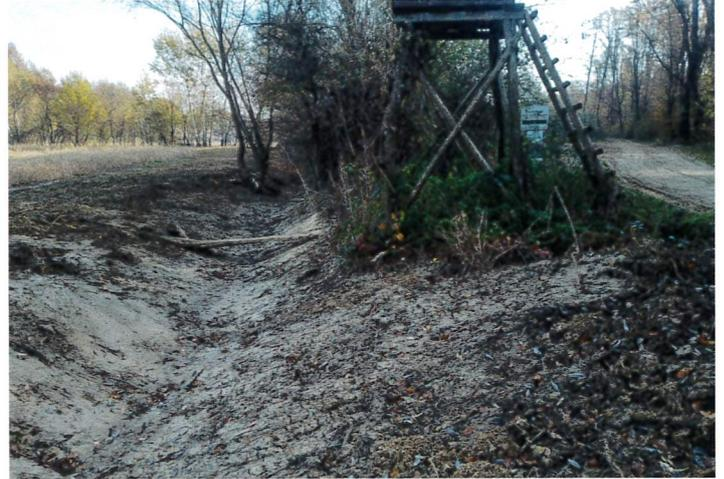
Im Zuge der Projektierung der Oberflächenentwässerung für die Schaffung der Baugründe Steinwiese war es erforderlich, den Entwässerungsgraben, welcher in die Rabnitz führt, zu vertiefen bzw. zu überarbeiten. Ein Großteil der künftigen Oberflächenentwässerung wird über diesen Graben abgeführt.
