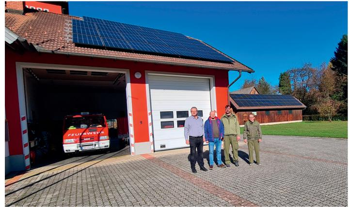
Um bei Stromausfall die Stromversorgung - und somit die Einsatzbereitschaft der Feuerwehr Liebing - zu sichern, wurde am Haupt- und Nebengebäude des Feuerwehrhauses eine Photovoltaikanlage mit Speicher errichtet. Gleichzeitig kann dadurch auch der Eigenverbrauch der Feuerwehr größtenteils gedeckt werden. Die Inbetriebnahme erfolgte am 10. November durch die Firma Harald Stampf aus Rattersdorf. Durch den persönlichen Einsatz der Mannschaft konnten die Errichtungskosten erheblich reduziert werden.
