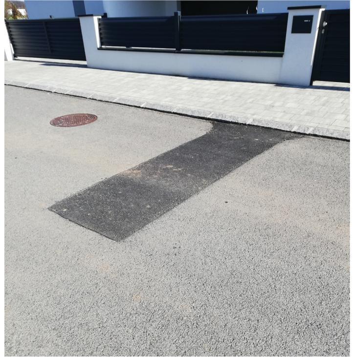
Am Güterweg Unterloisdorf Richtung - Kleinmut-schen wurde der beschädigte Asphalt mit einem Fugenverguss instandgesetzt.
