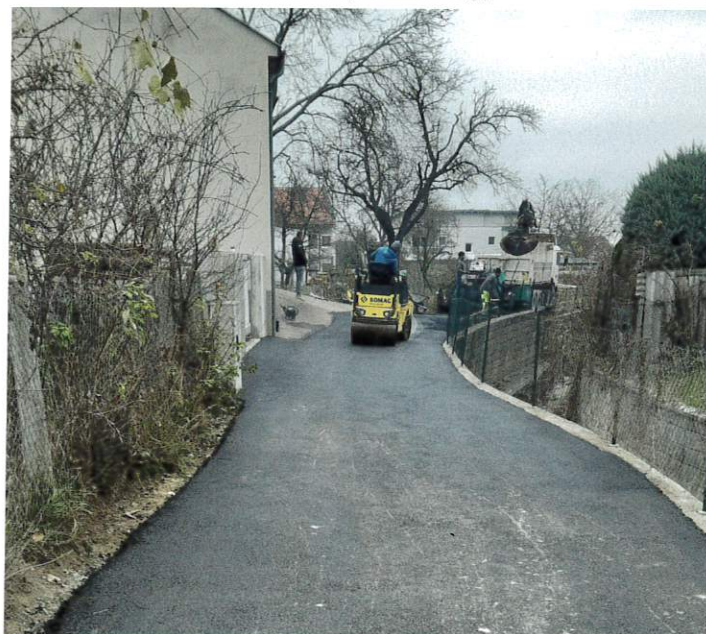
Asphaltierungsarbeiten Begleitweg Dorschabachgasse
